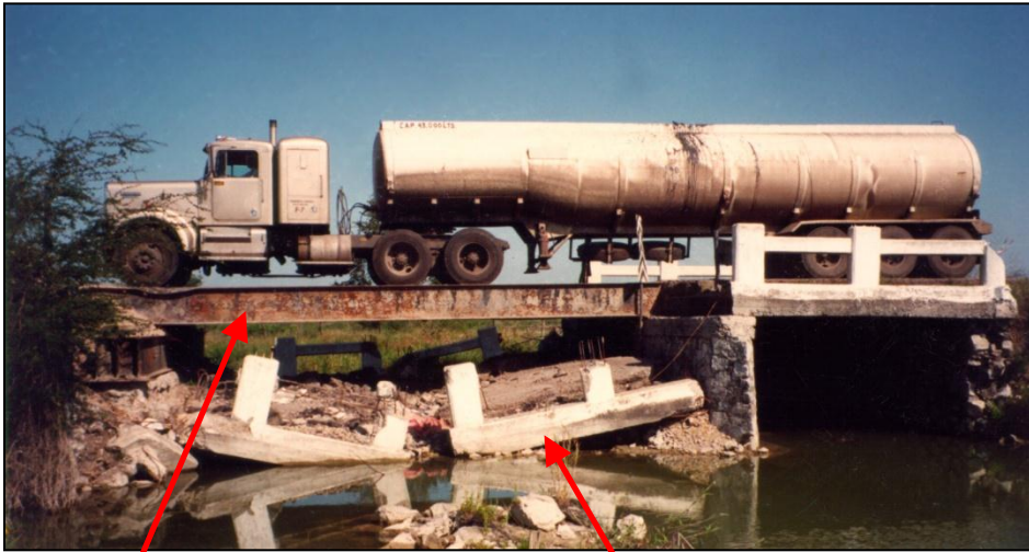
Nødbro sat op efter at betonbroen fejlede
