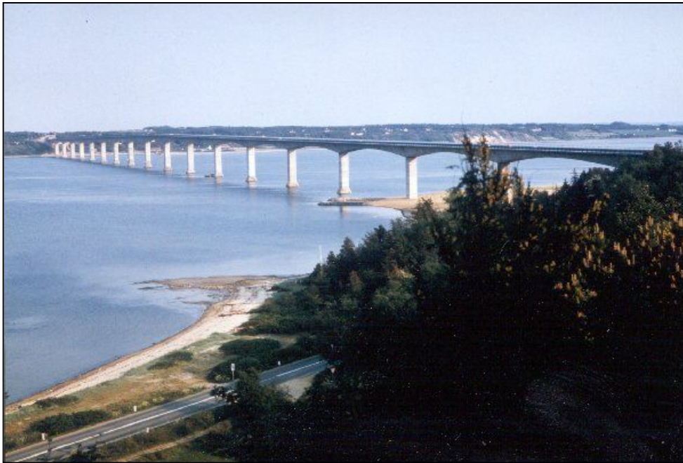
Sallingsundbroen med hoveddrager som en kontinuert bjælke.
