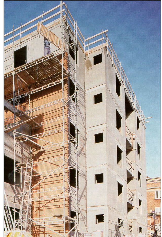
Præfab væg- elementer i boligblok
